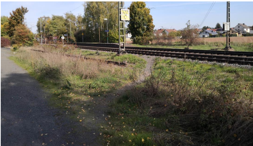
Abbildung 46: Trampelpfad über Bahngleise südlich des Bahnhofs
