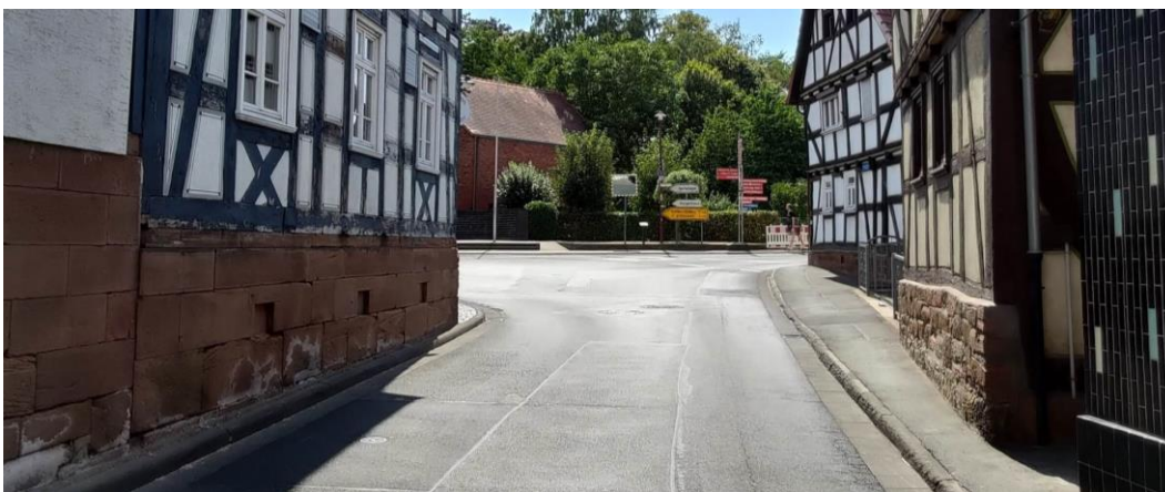
Abbildung 30: Knotenpunkt Rathausstraße/Bahnhofstraße (Blickrichtung Süd)
