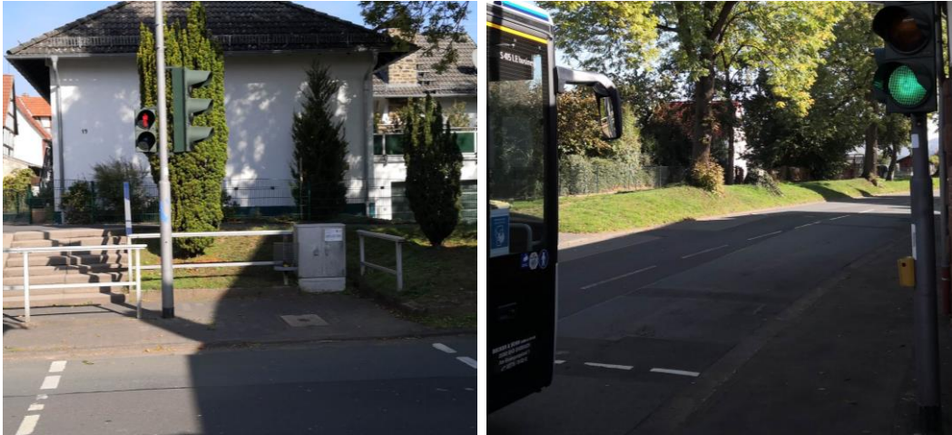
Abbildung 8: Fußgänger-Lichtsignalanlage in der Gießener Straße
